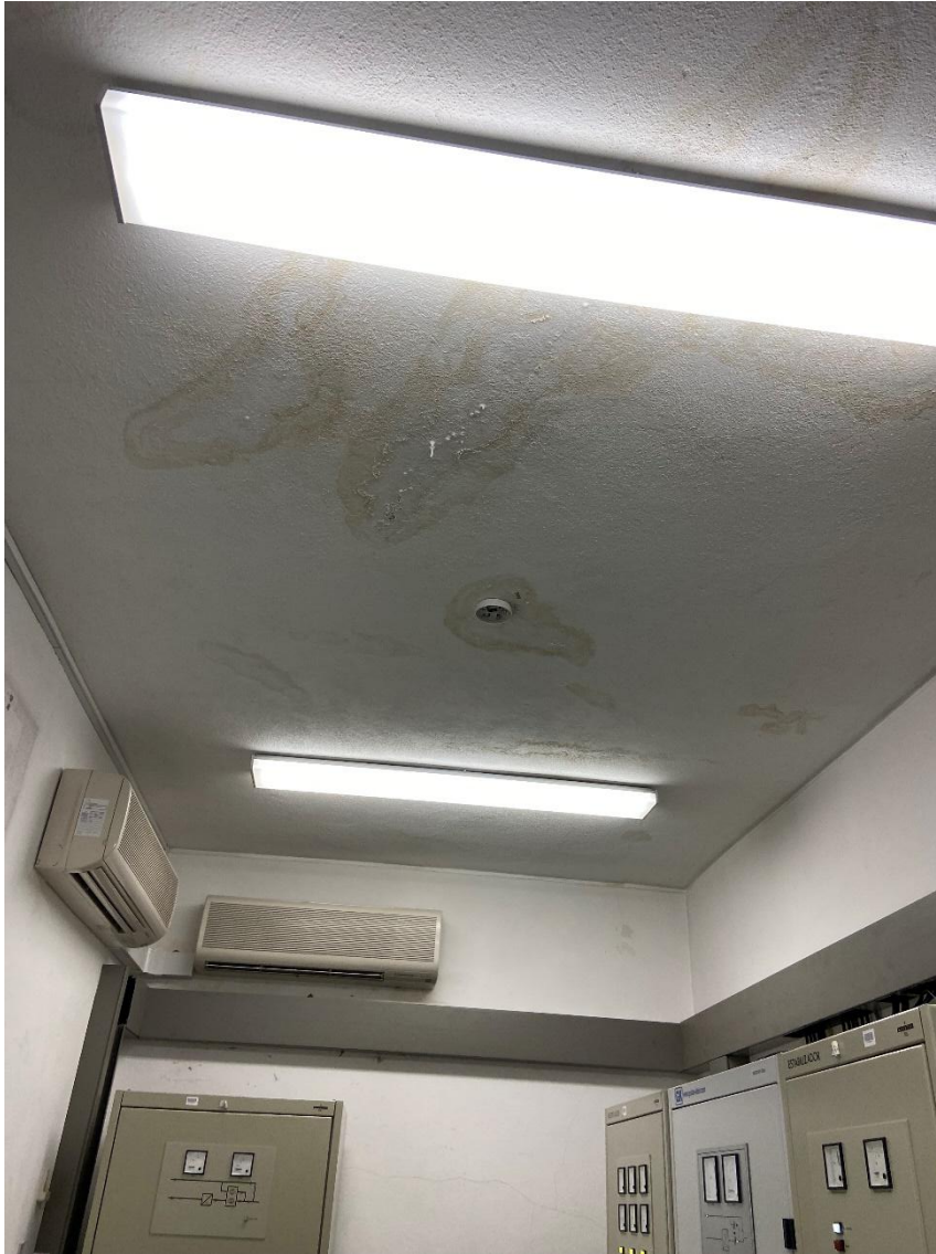
A sala de energia de Vermoil apresenta infiltrações
