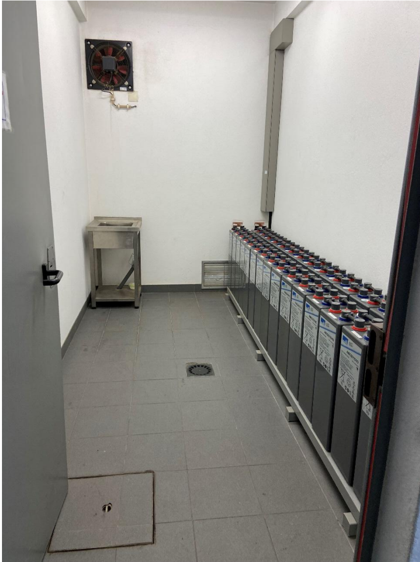
Sala de baterias de Fátima com capacidade para mais equipamento
